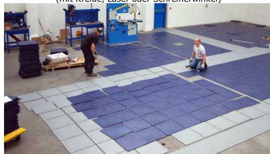
*Bild Nr. 4 teilen Sie bitte die Palette auf und verlegen Sie die Fliesen lose, bevor Sie mit dem Fixieren anfangen*
