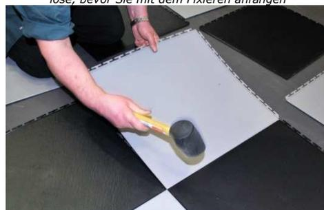
*Bild Nr. 5 Beginnend von einer Ecke, mit wenig Druck zwei Fliesen mit dem Gummihammer klopfend, kreisförmig verbinden*
