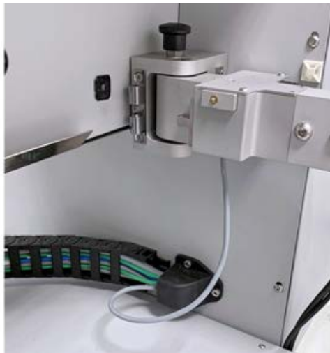
Fig. 15: Pose de câble à l'extérieur du boîtier, photo après la fin de l'assemblage.
